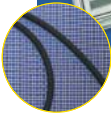
Fliegengitter, befestigt durch Aufziehen eines Neoprenrings.
